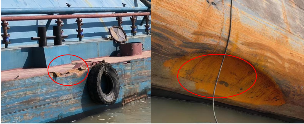
图 30：“浙桐乡槽 00878”轮损坏情况
