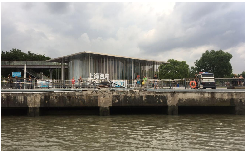
图 4 徐汇滨江亲水平台
