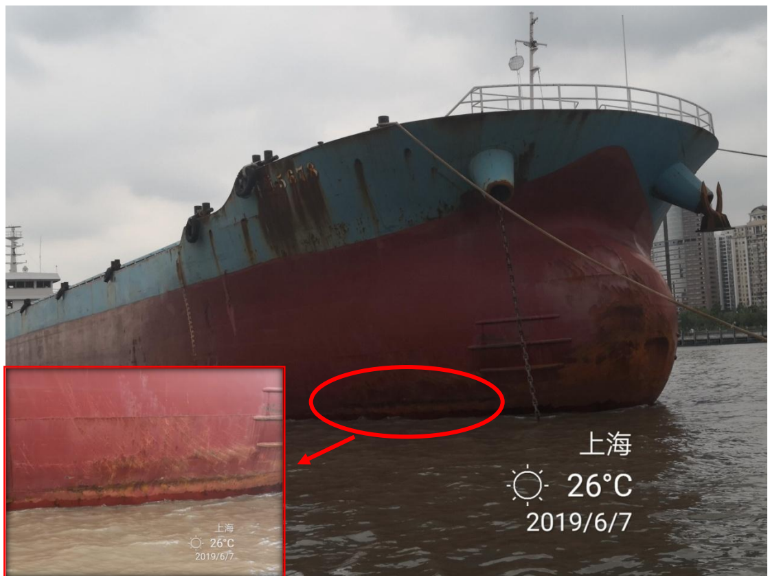
图7：“润航XX”轮右舷损坏情况照片。
