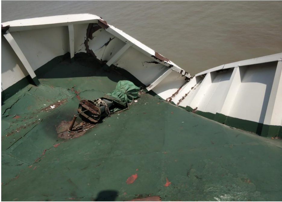
图 6：“正和 58”轮翼甲板损坏情况
